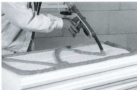
Abb. 4.3: Μηχανική διάστρωση της κόλλας στην πίσω πλευρά μιας πλάκας EPS με περιμετρικό κορδόνι και ζικ ζακ στο εσωτερικό
