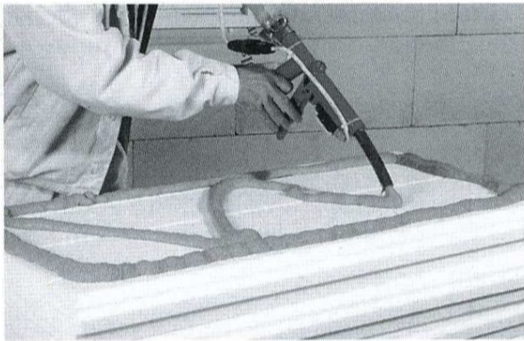
Abb. 4.3: Μηχανική διάστρωση της κόλλας στην πίσω πλευρά μιας πλάκας EPS με περιμετρικό κορδόνι και ζικ ζάκ στο εσωτερικό
